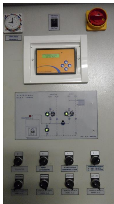
Figura 4.21 – Posizionamento generatore di calore Figura 4.22 - Centralina climatica con cronotermostato.
