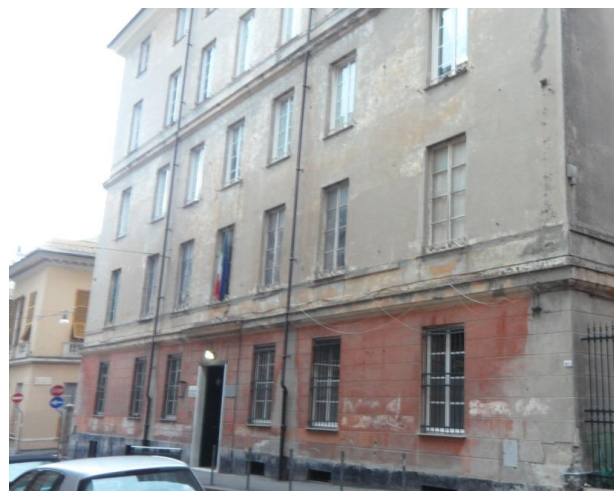
Figura 4.1 – Facciata esterna – Via Vincenzo Ricci 6
