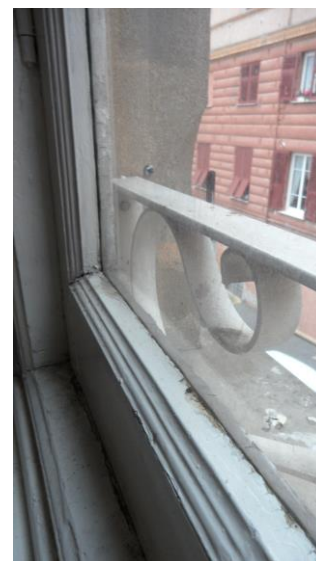
Figura 8.2 – Infissi esistenti con telaio in legno e vetro singolo
