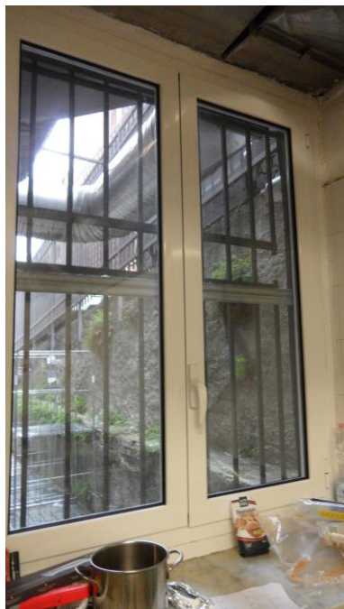
Figura 4.10 – Serramenti in legno e vetro singolo
